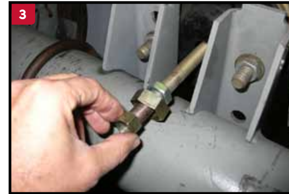
3 Coloque una tuerca de 1/4" en las espiga contra la tuerca de 15/16" de la varilla. Enrosque la tuerca de 3/4" en la varilla.
